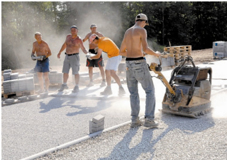
Die Heim(at)werker vom FC bauen einen Gehweg um den neuen Kunstrasenplatz GB-Foto: Holom
